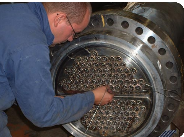
Монтаж hiTRAN . Собственность: KCC
